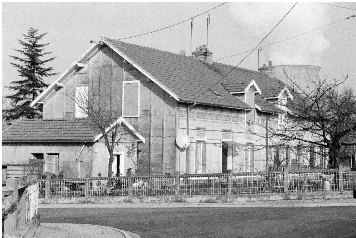
Bâtiment à 4 logements ouvriers de " type 1 " dit " murs minces ".
