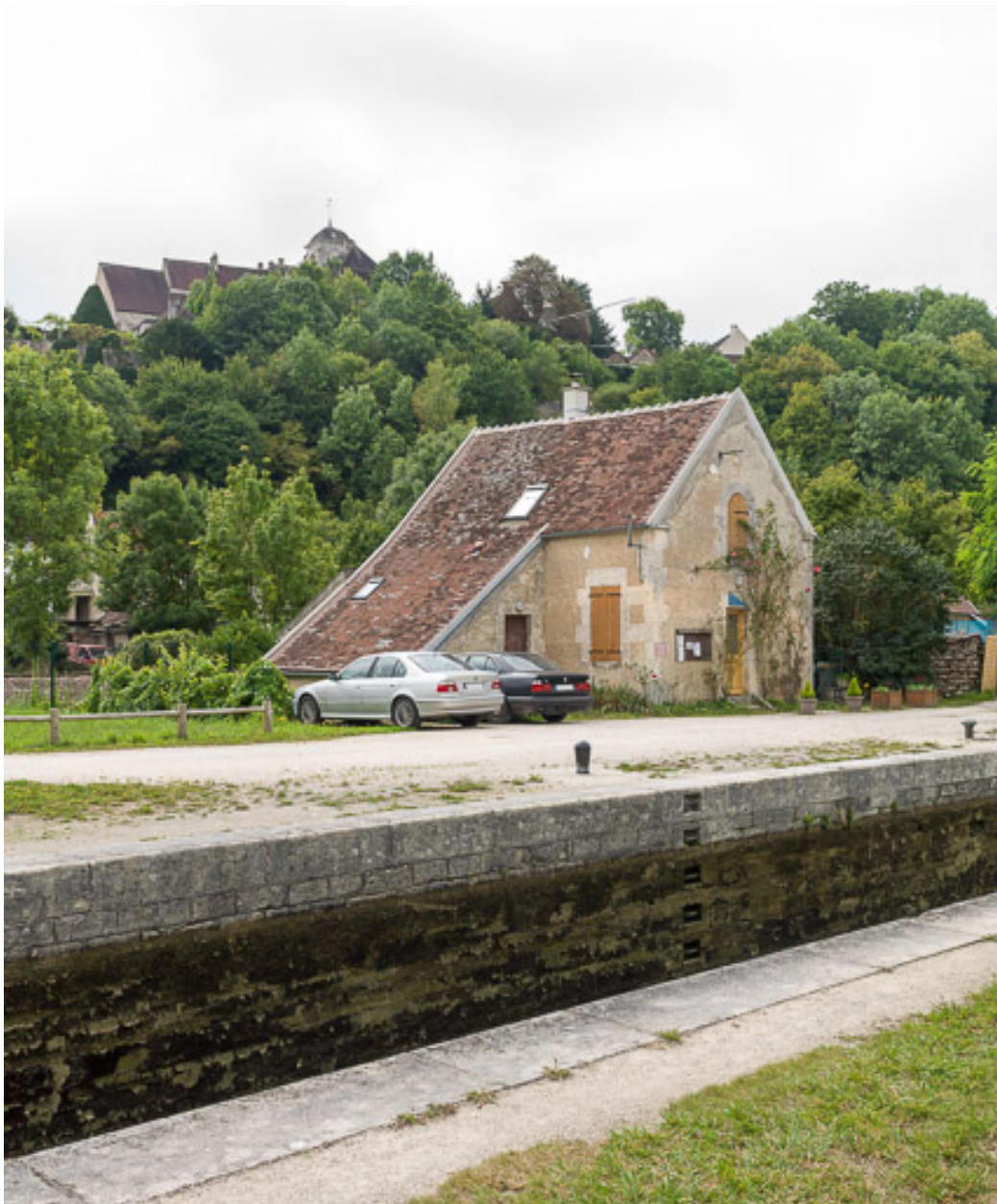
Vue de la maison éclusière.
