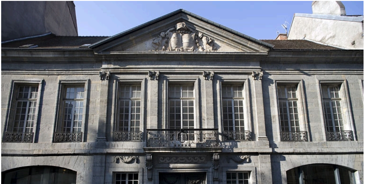
Vue d'ensemble du premier étage de la façade sur rue, de face.
