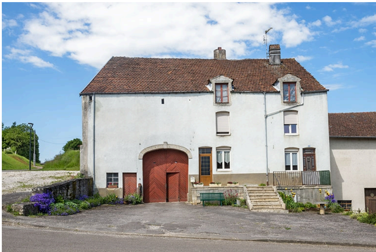
La façade antérieure depuis la rue.
