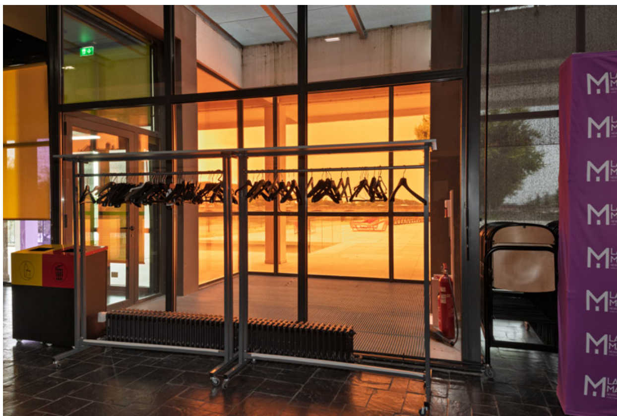
Maison de la culture : salon Thuriot, détail des baies.
