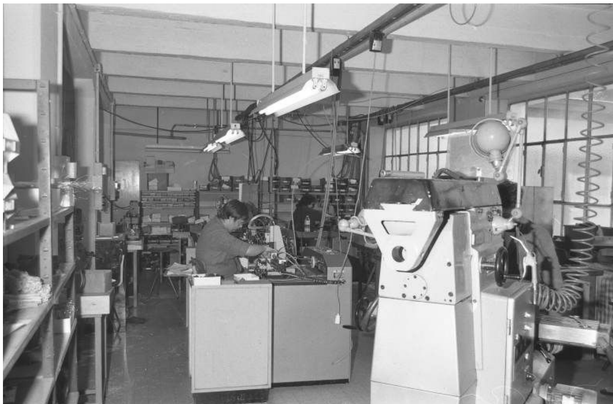
Intérieur d'un atelier dans le bâtiment d'origine.
