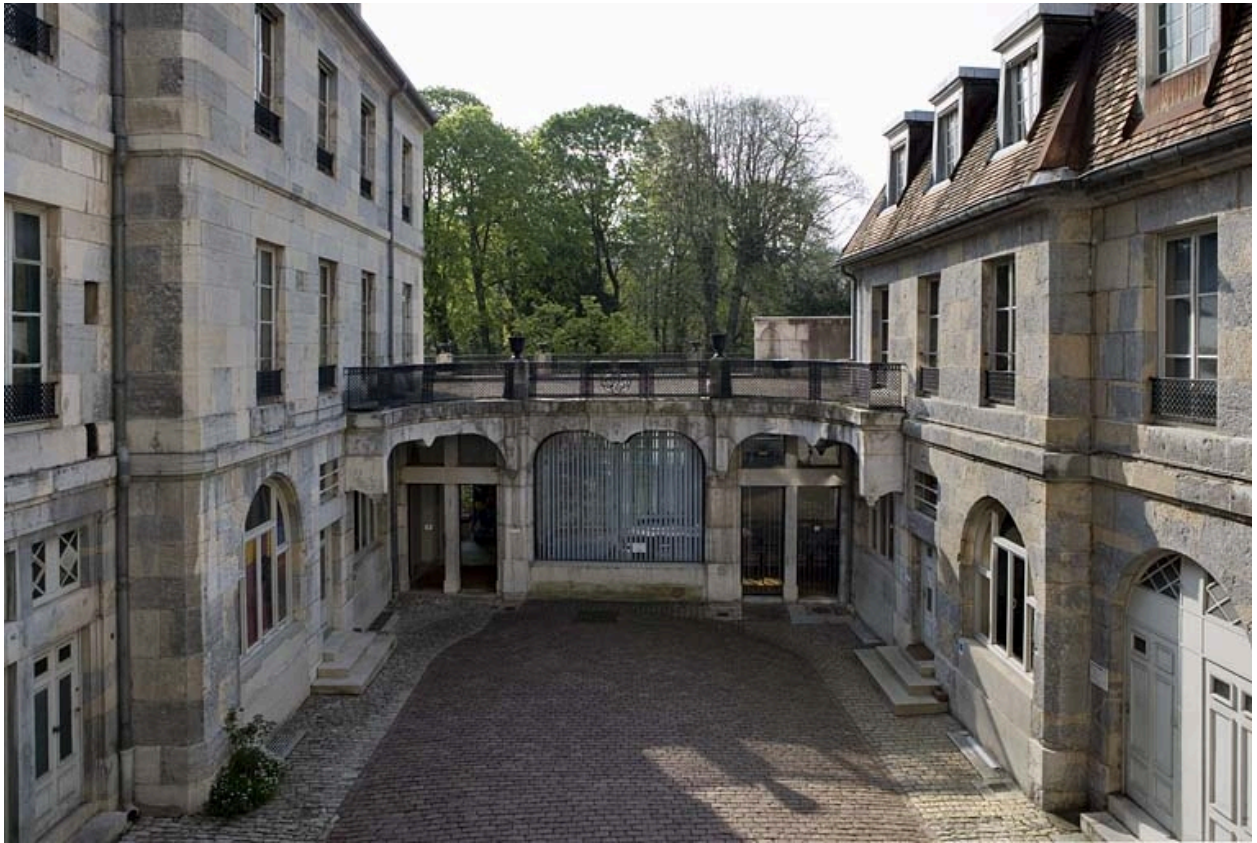
Vue d'ensemble des deux ailes et du jardin d'hiver depuis l'entrée de la cour.
