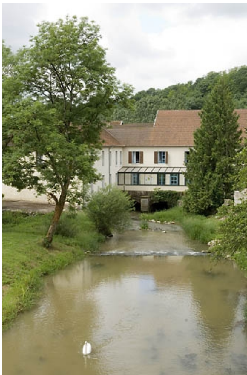
Bief d'amenée à l'usine.
