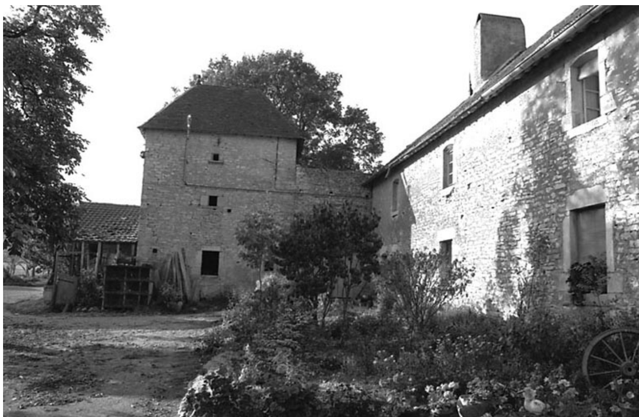
Partie d'habitation : vue d'ensemble.
