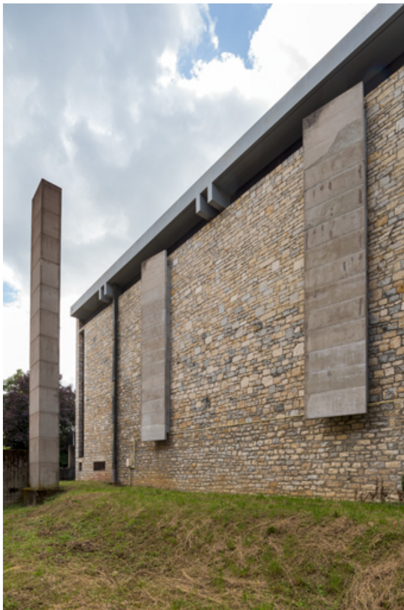
Façade latérale droite. Vue de trois quarts.
