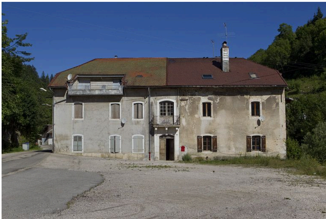
Morez : usine d'horlogerie et scierie Prost Frères, 2 à 10 rue des Forges.
