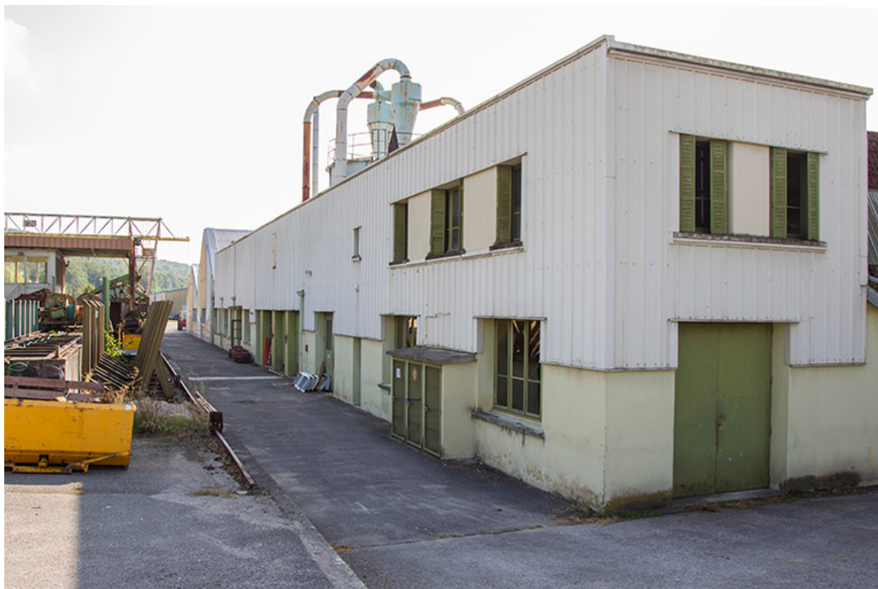
Atelier construction : façade antérieure.
