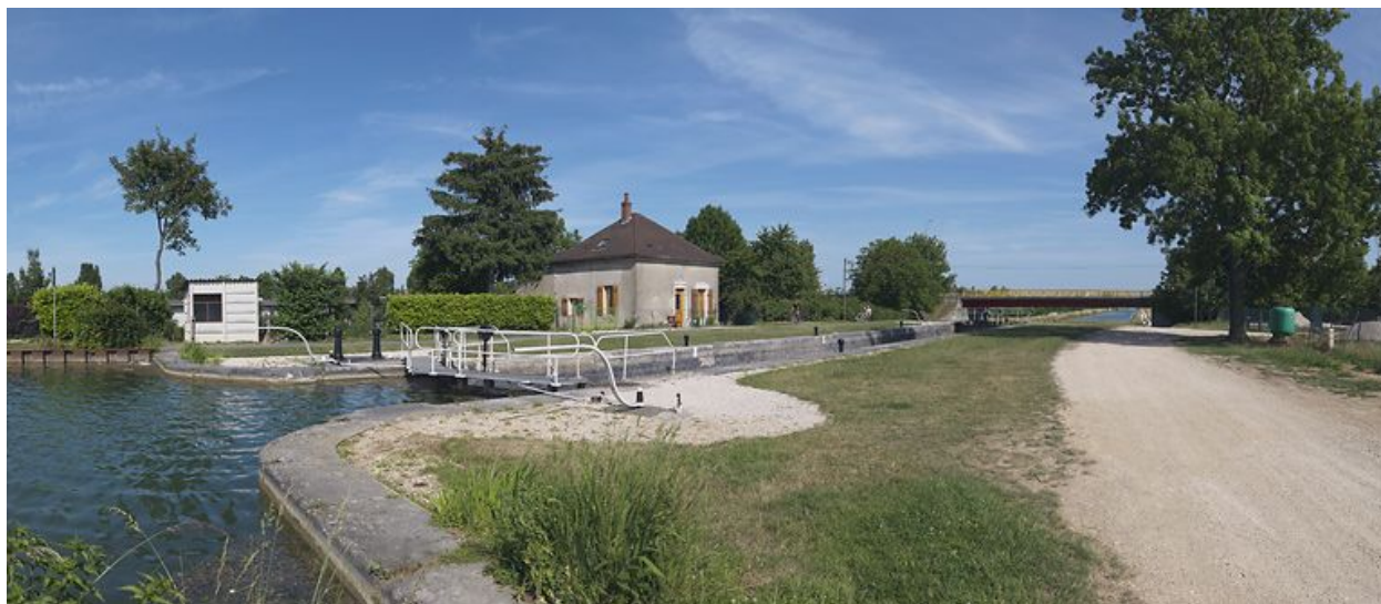
Site d'écluse de 3/4 amont. Vue large.
