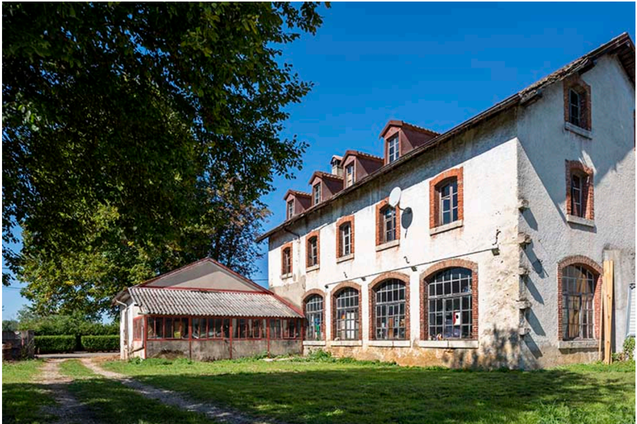
Forge (façade postérieure) et atelier principal (façade latérale droite).
