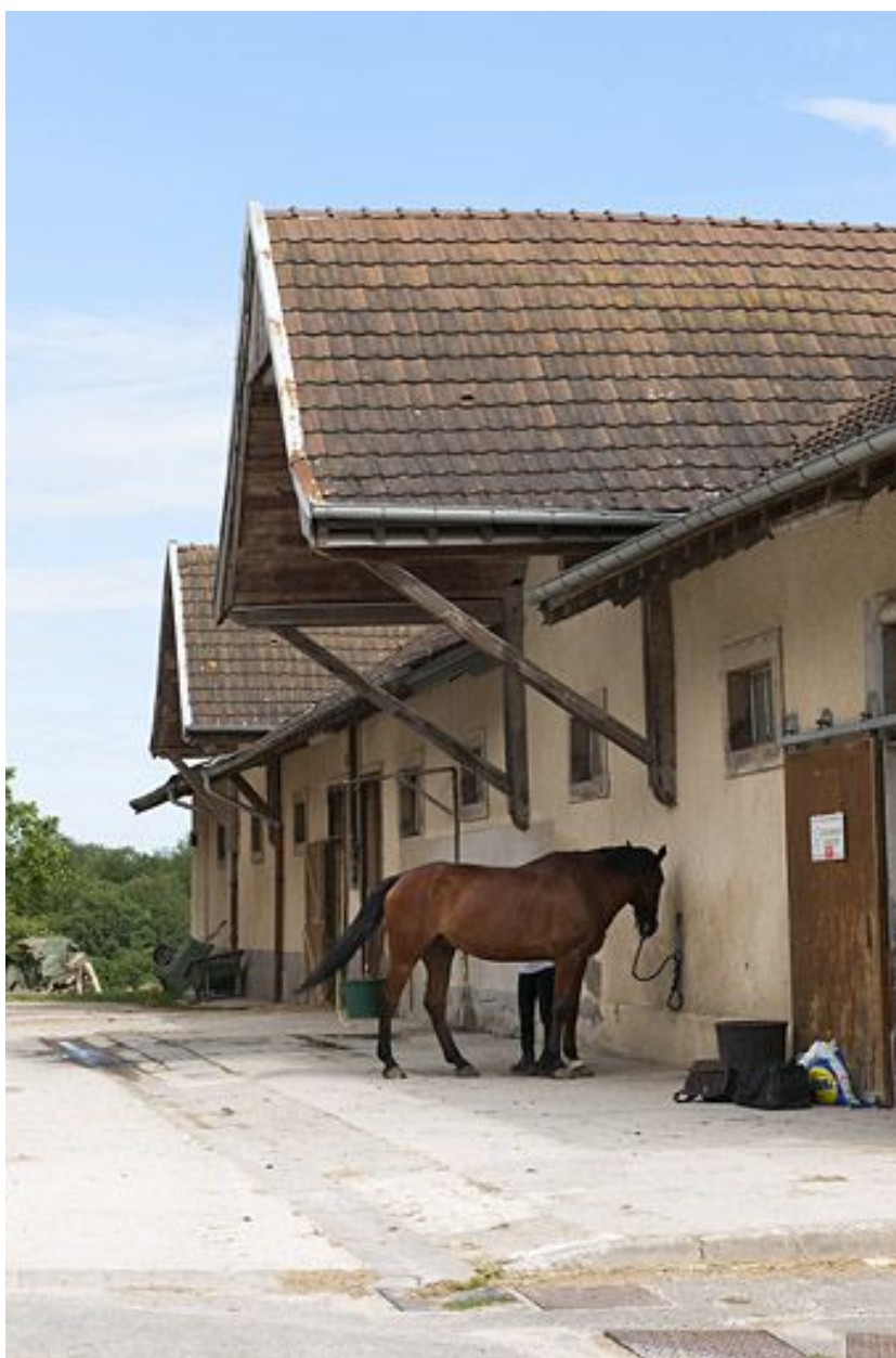
Ancienne étable. Vue de trois quarts.
