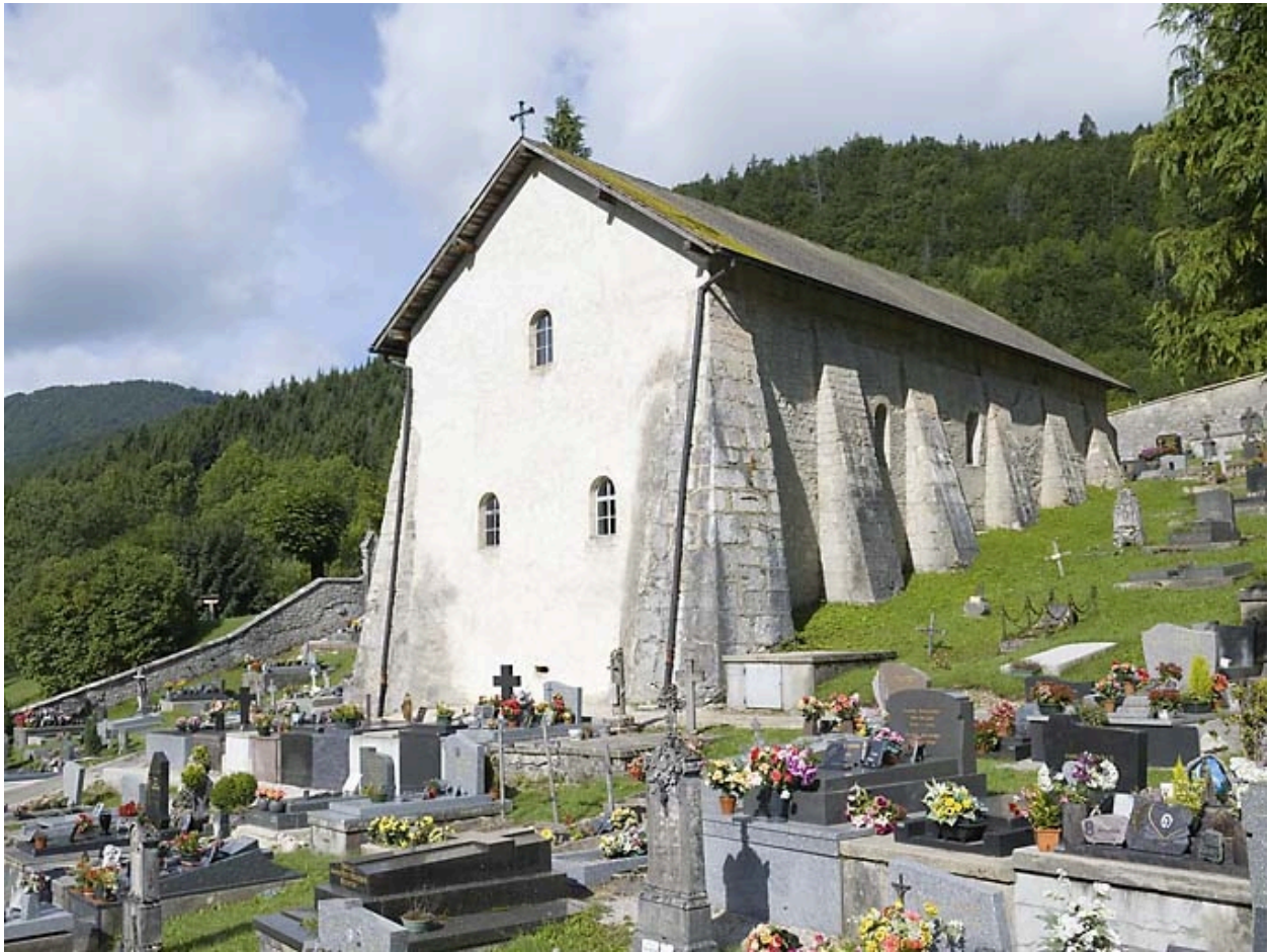
Vue générale rapprochée, depuis le sud-est.
