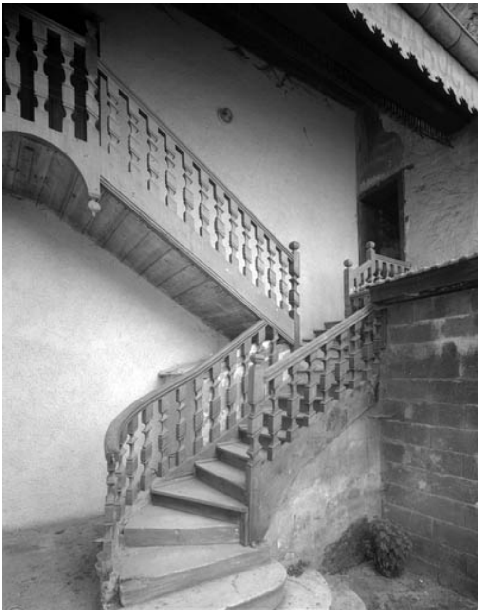
Détail de l'escalier extérieur : vue rapprochée.
