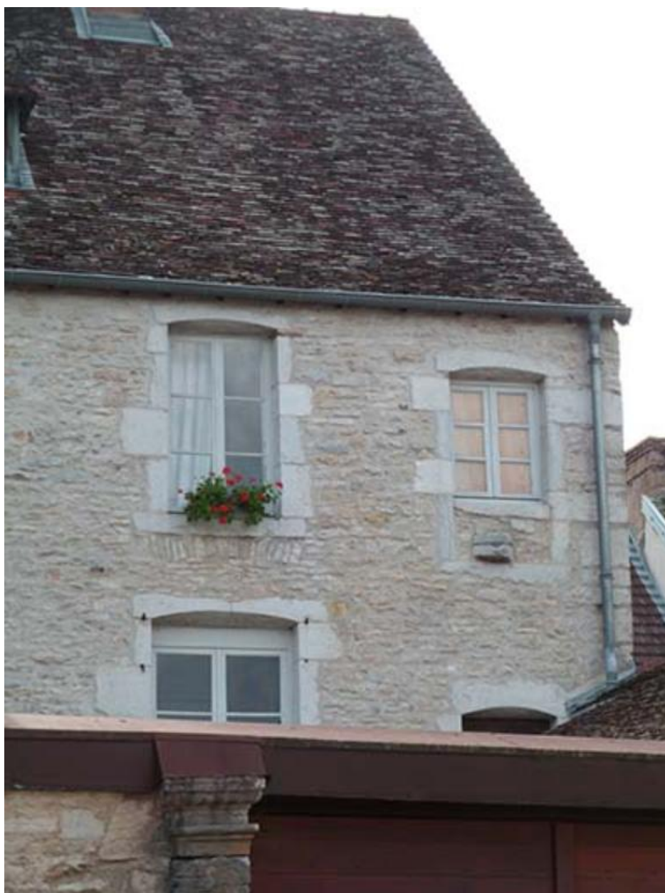
Détail des baies de l'étage
