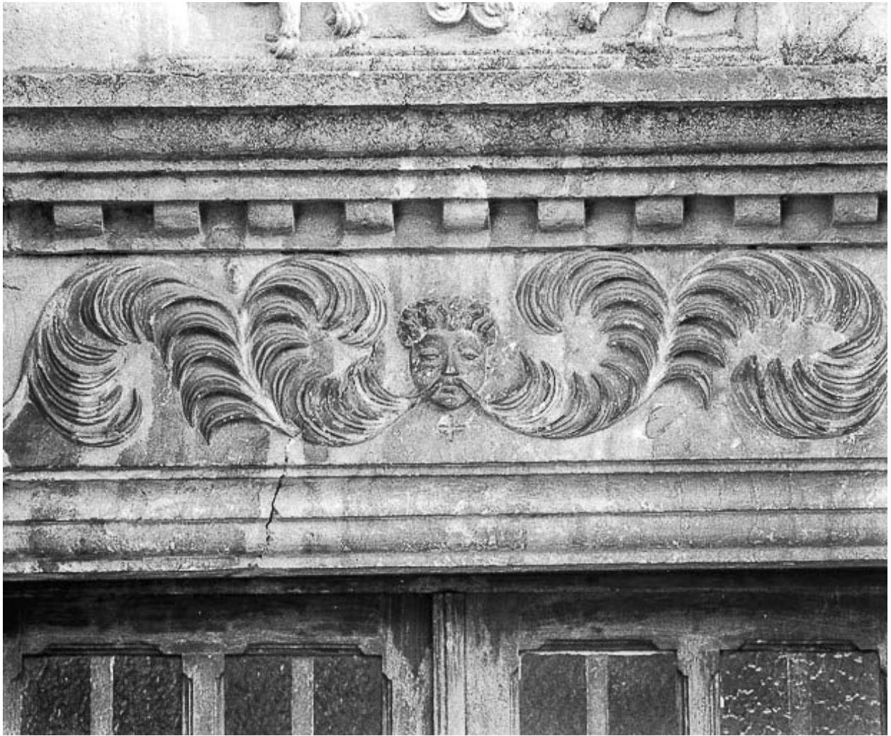
Linteau de la porte d'entrée.
