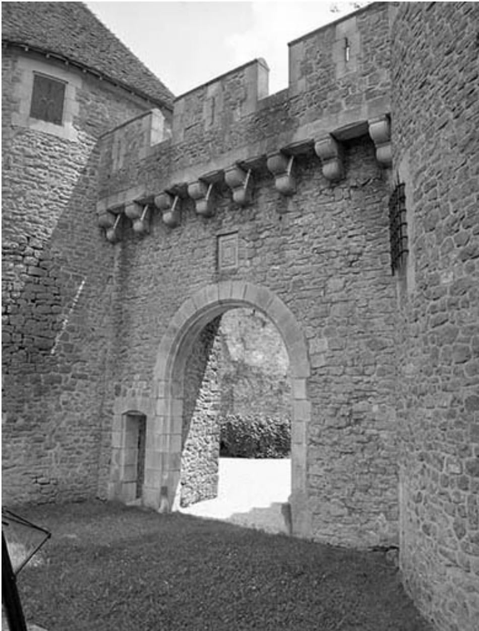
Portail nord : vue de trois quarts.
