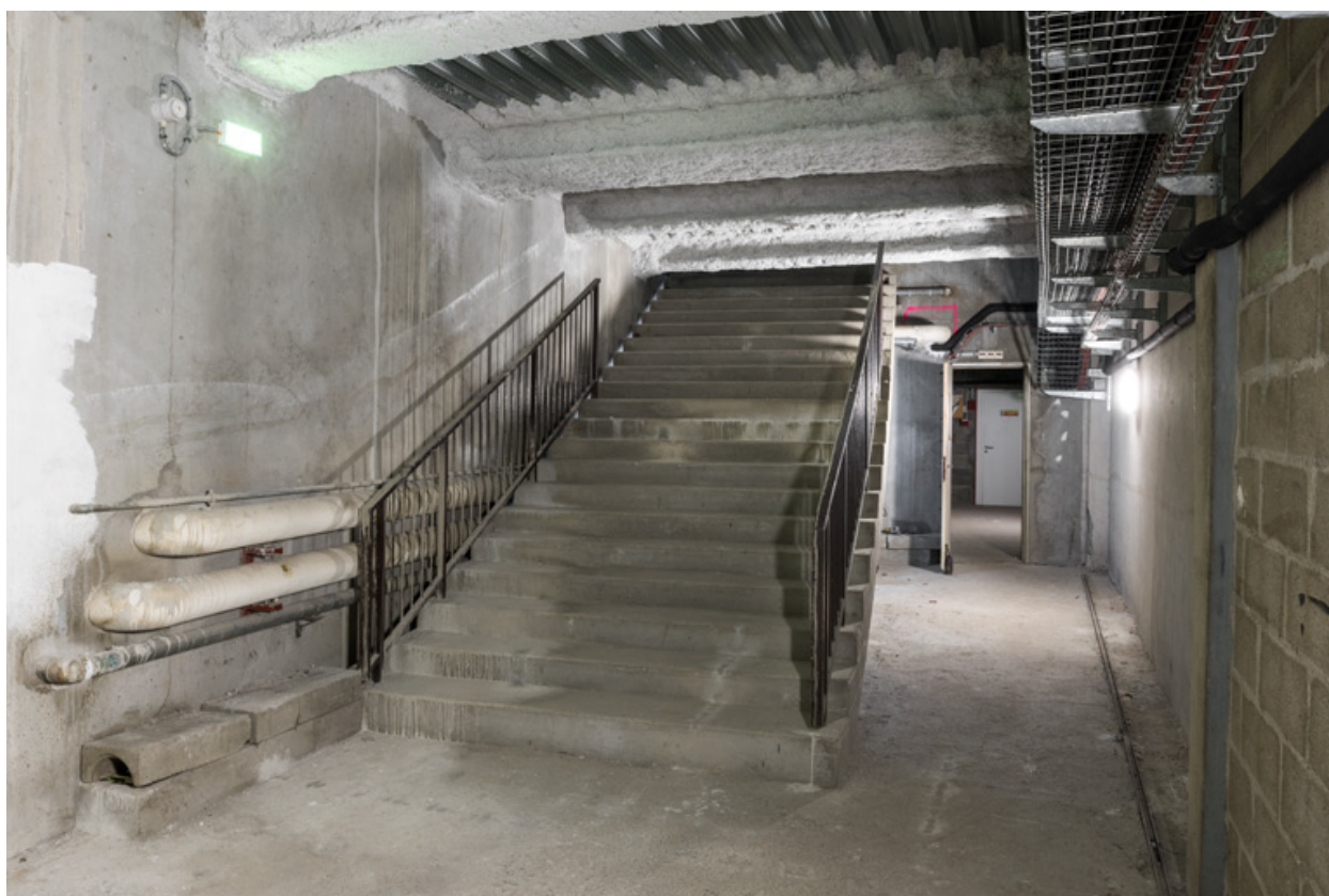
Maison de la culture : escalier menant à la maison des sports, sous le hall.
