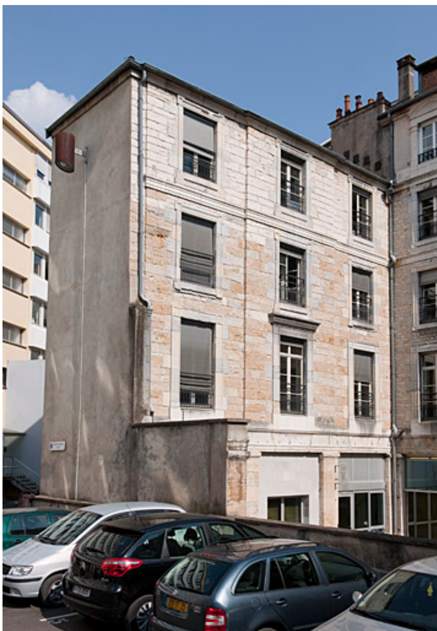
Vue d'ensemble de l'aile gauche sur cour.
