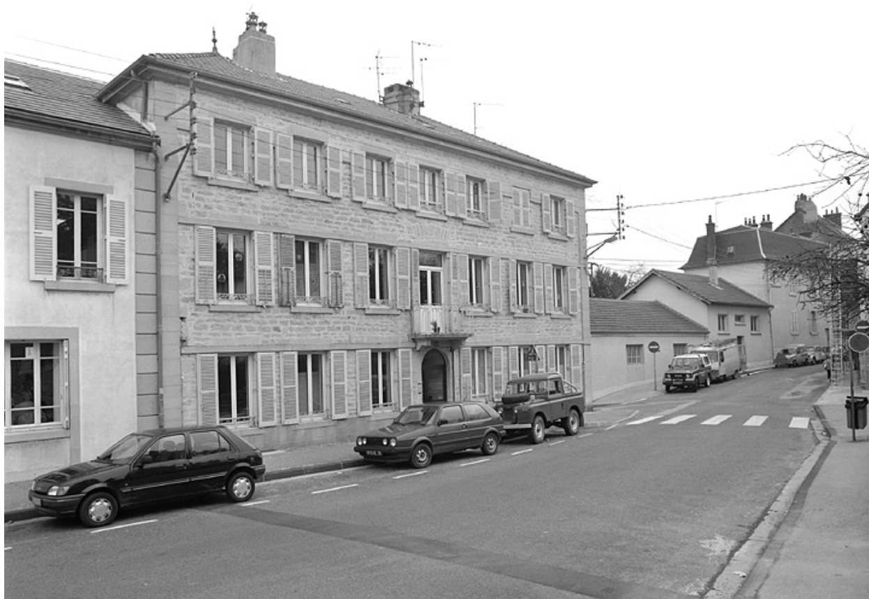
Façade antérieure du logement.
