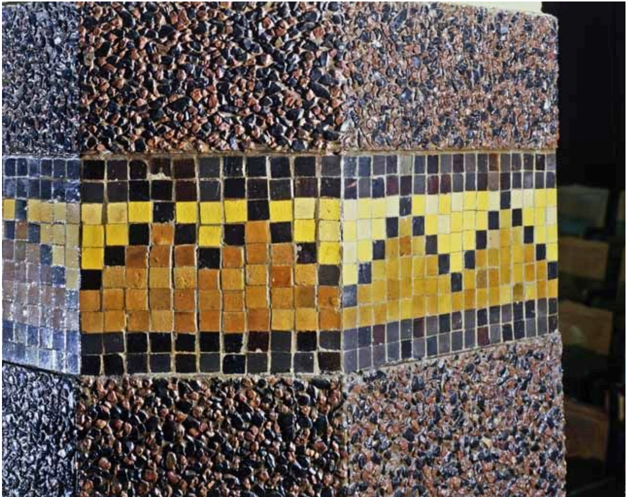
Bâtiment B, grand amphithéâtre : revêtement de gravillons et mosaïques.
