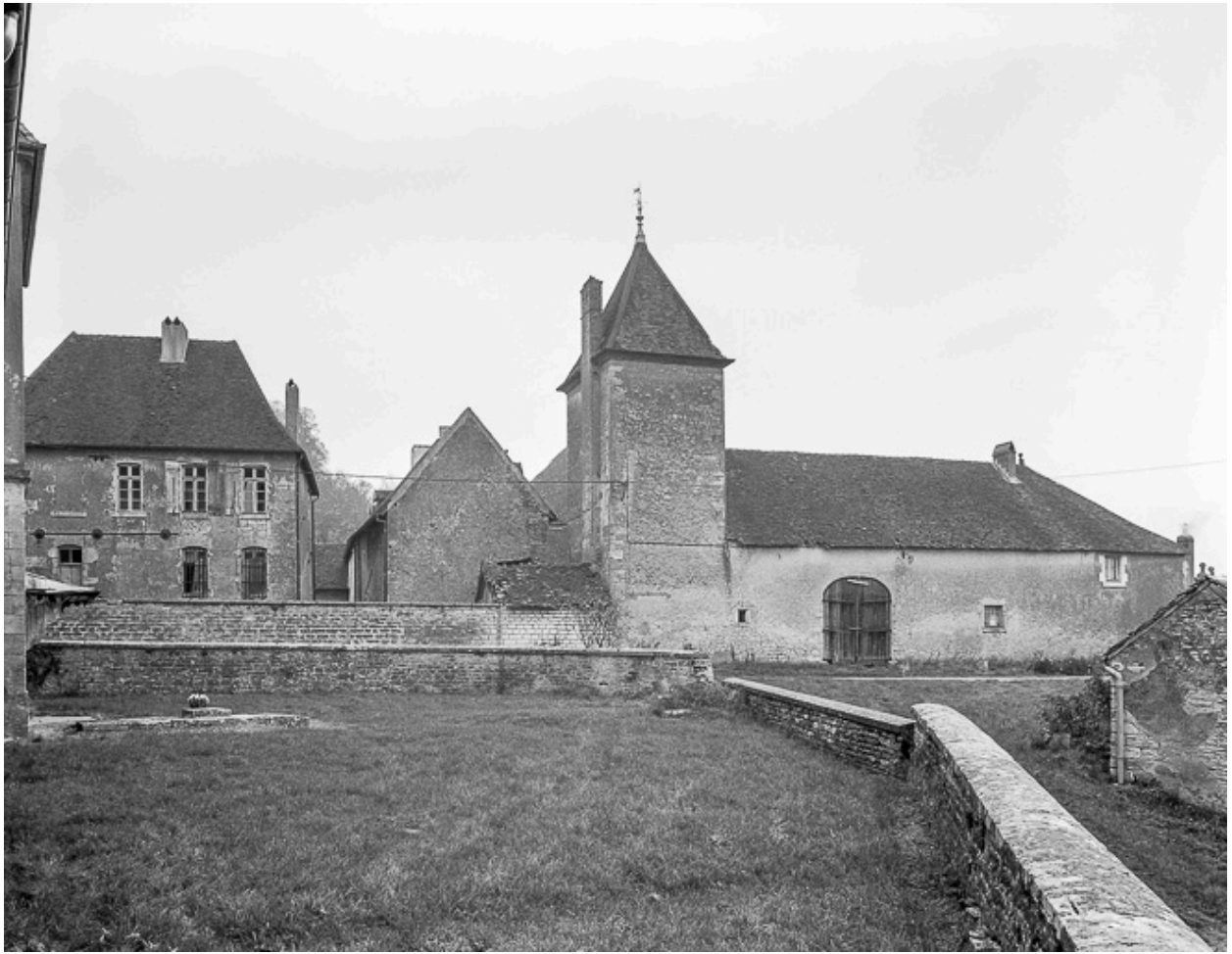
Vue d'ensemble de la partie gauche.
