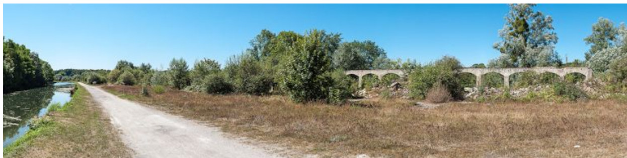
Vestiges des installations de la scierie de pierre de Chassignelles.
