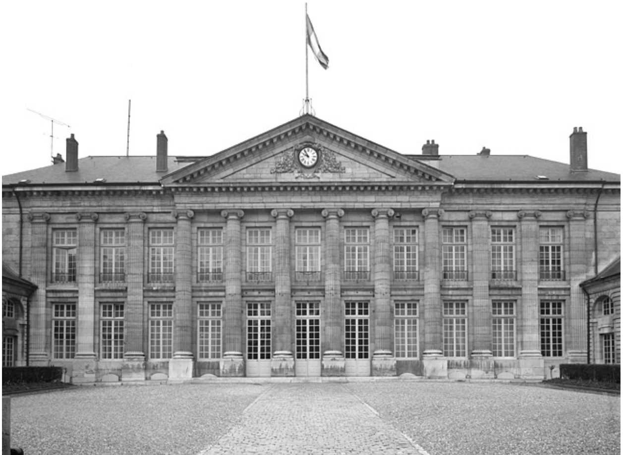
Façade antérieure, de face.
