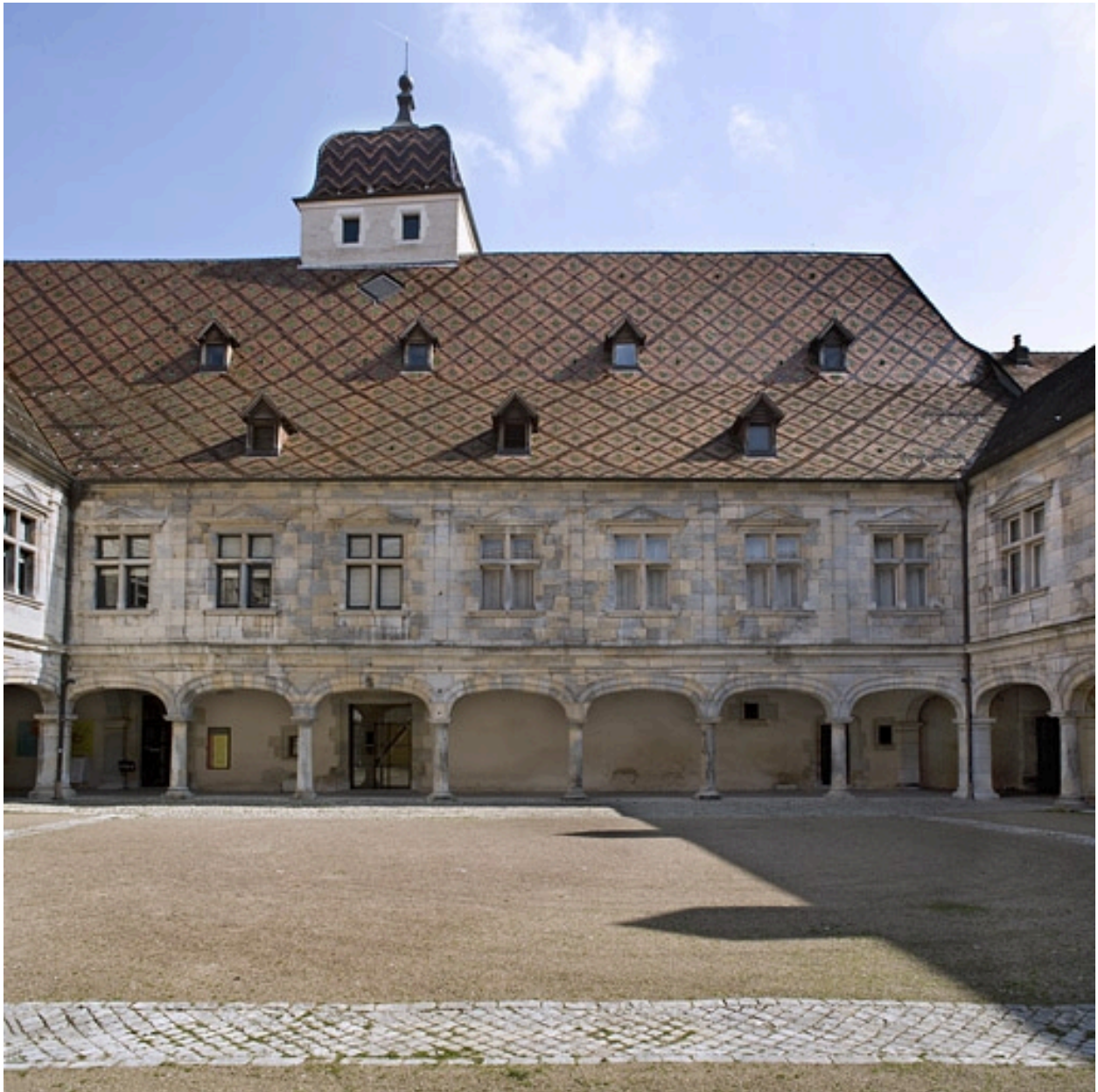
Vue d'ensemble de la façade sur cour du corps de bâtiment gauche.
