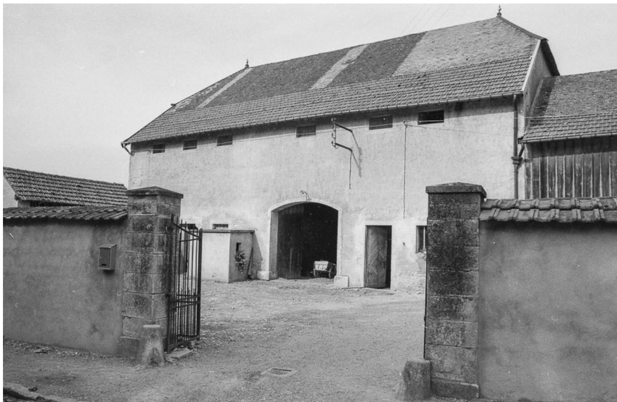
Bâtiment agricole dans la cour de gauche.
