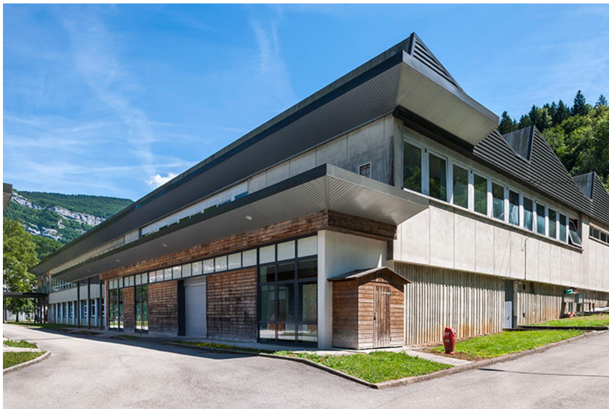
Atelier : vue d'ensemble.
