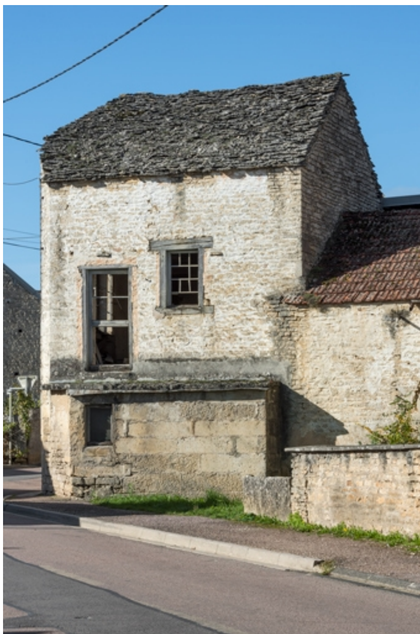
Détail de la façade est.
