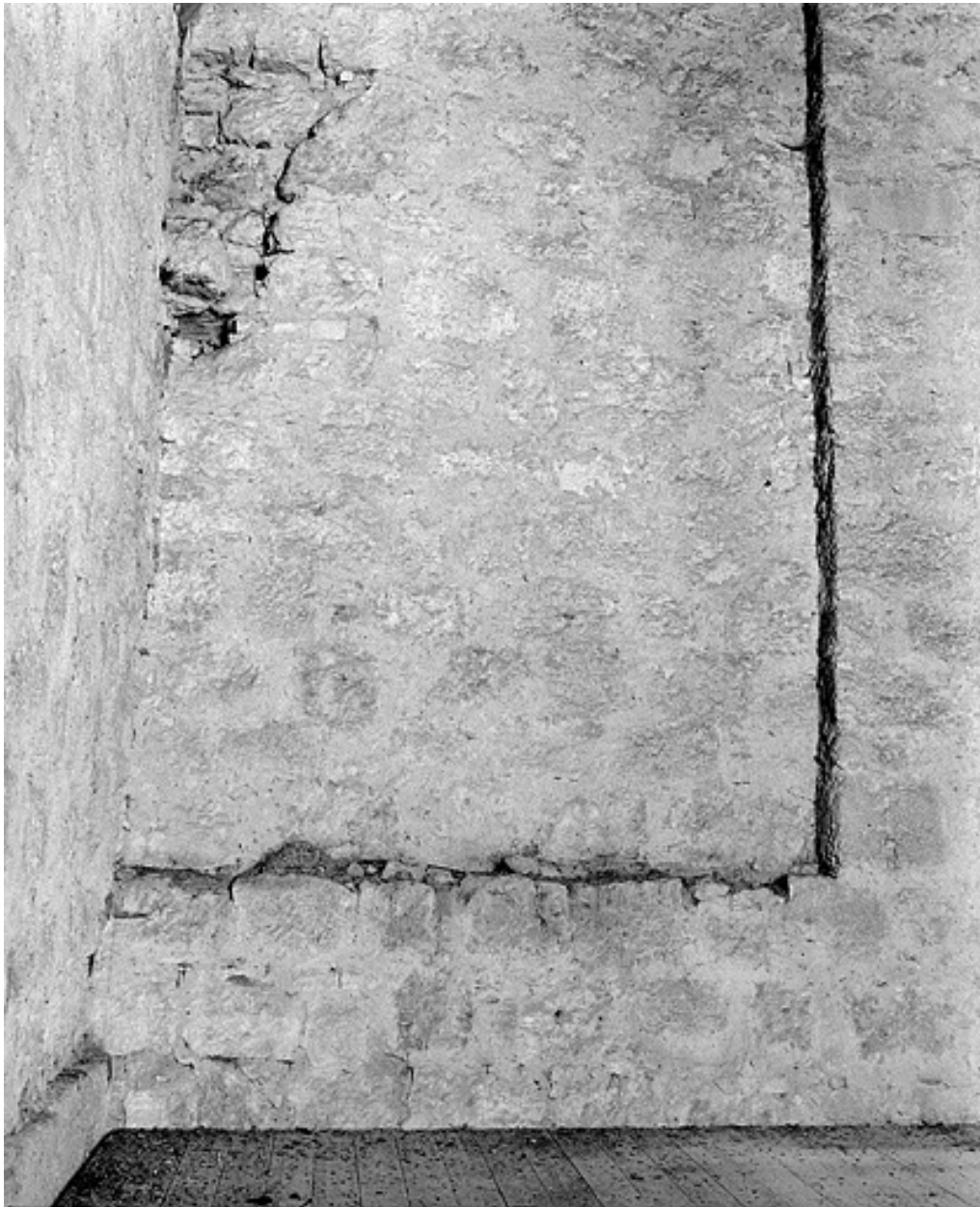
Détail du parement des parties hautes du clocher.
