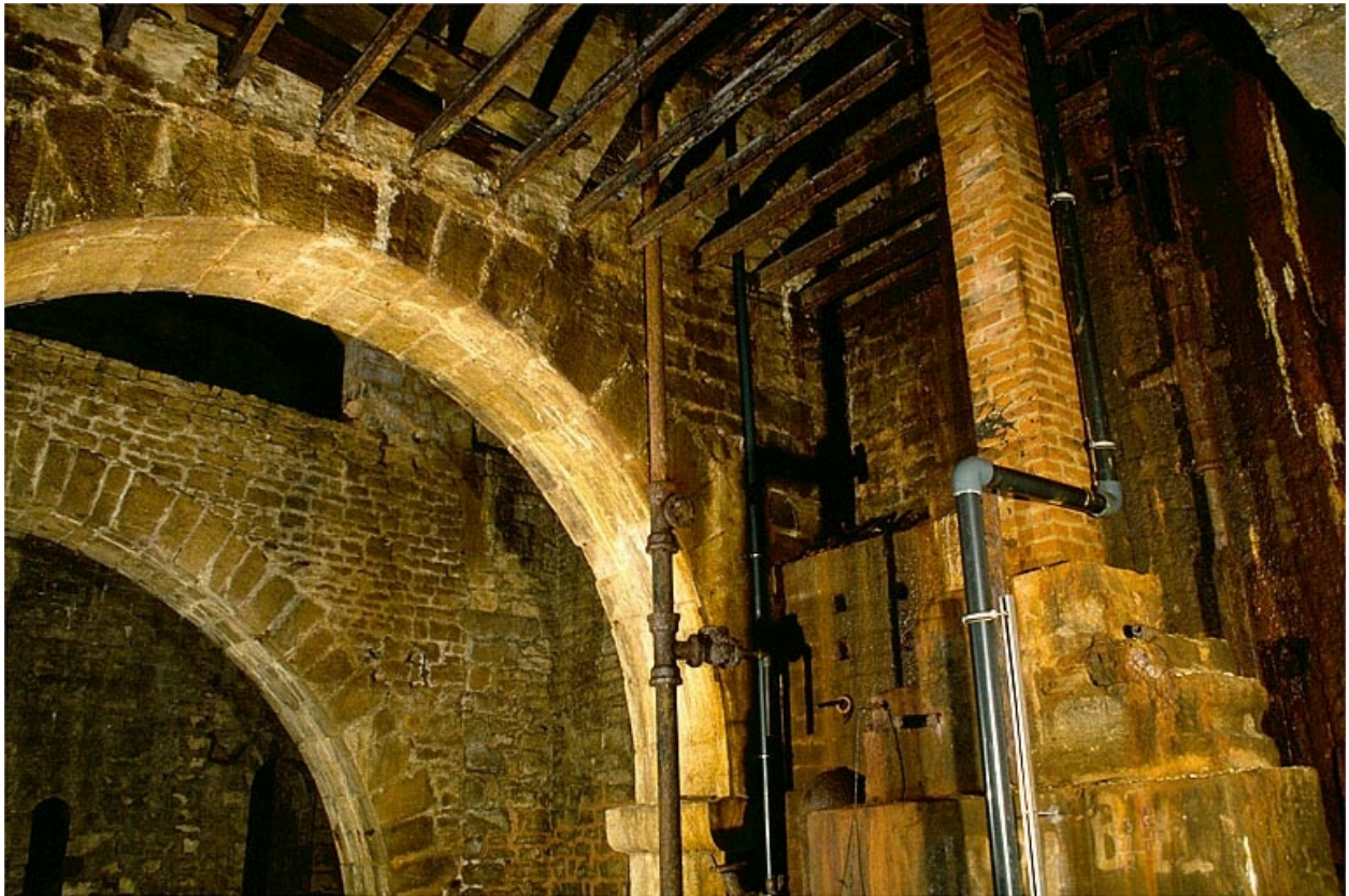
Parties supérieures du puits à Muire.
