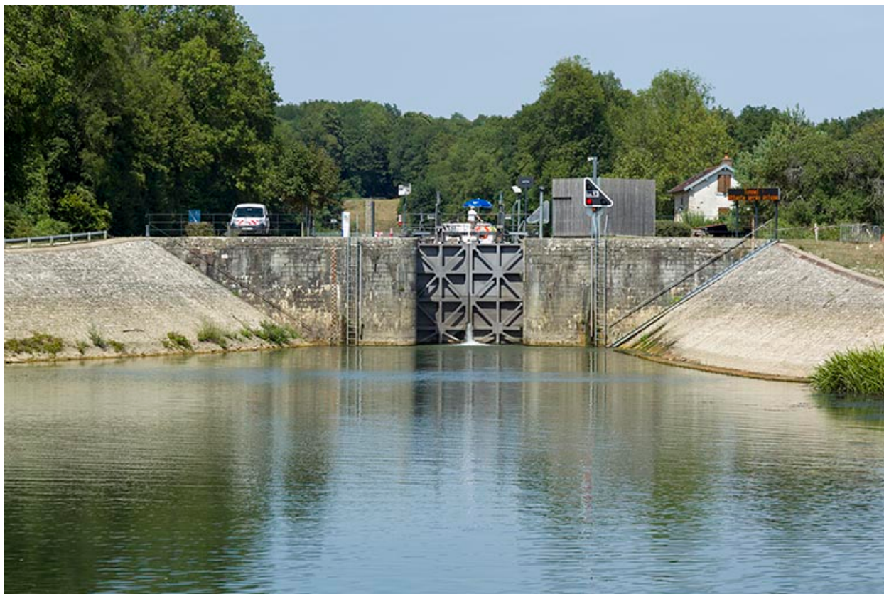
Vue aval, avec les perrés maçonnés.
