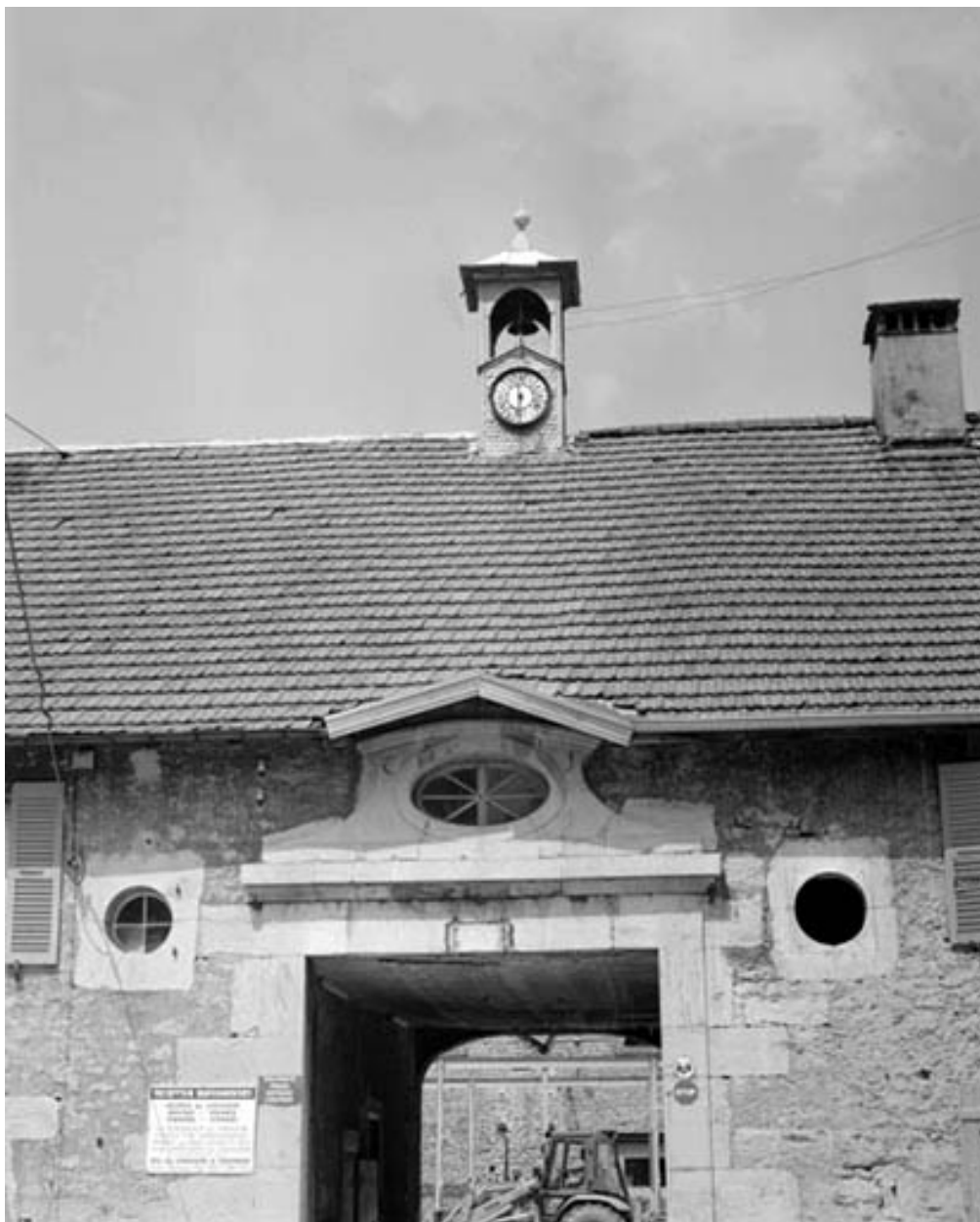
Porche d'entrée de l'usine.
