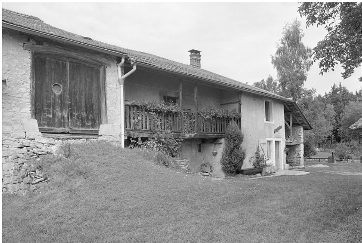
Façade antérieure, balcon en galerie.
