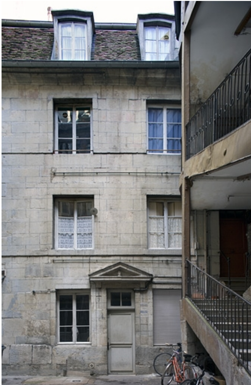
Vue de la façade sur cour du logis secondaire.
