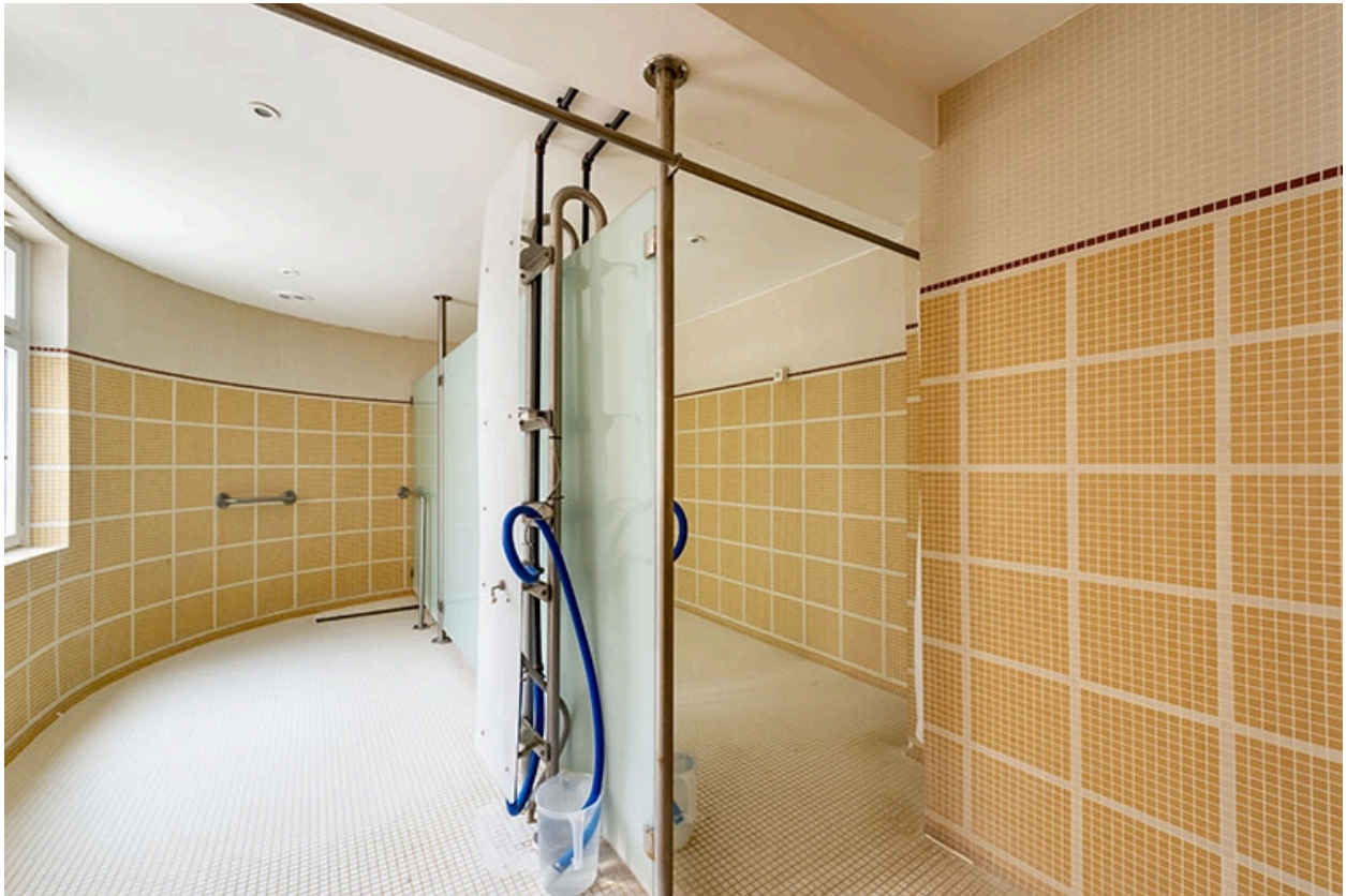
Bâtiment d'Hygie, salle de la douche à jet au premier étage.
