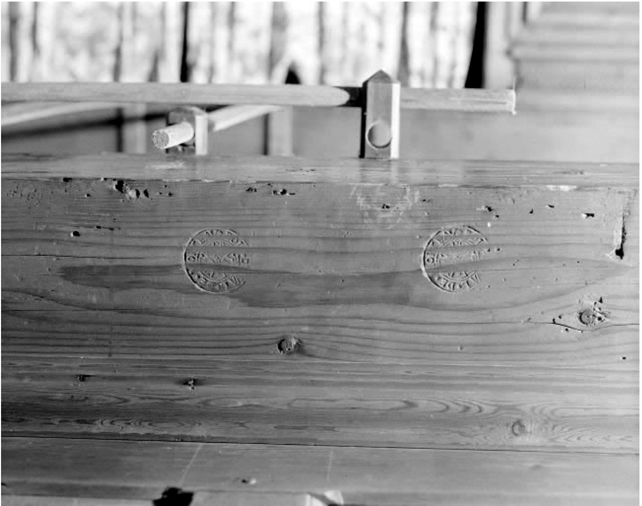
Intérieur : le "poêle", détails : sceaux du val de Morteau.
