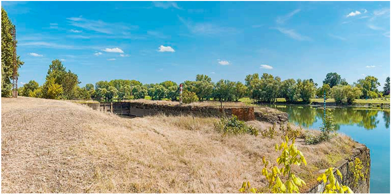
L'ancienne écluse de Verdun au premier plan.
