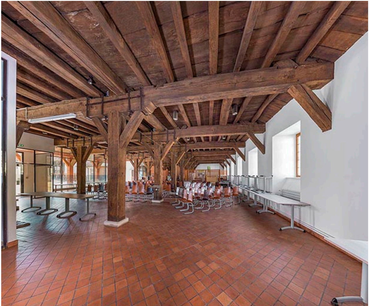
Rez-de-chaussée des grandes halles avec plafond en charpente apparente.
