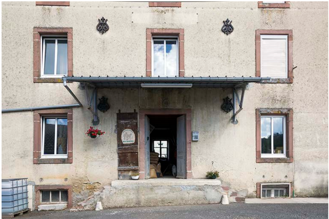
Minoterie : partie centrale de la façade antérieure.
