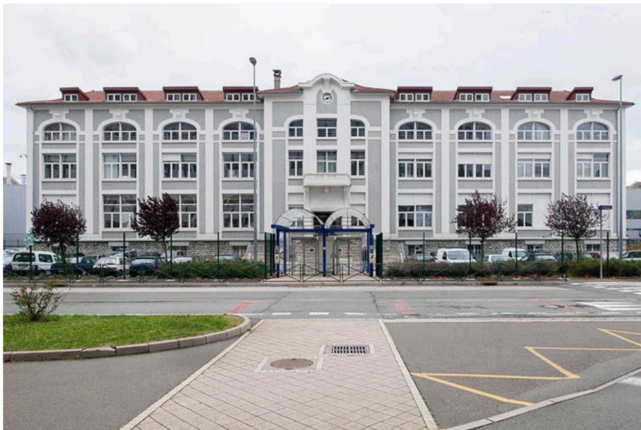
Bâtiment du Cercle à l'usine Peugeot de Sochaux-Montbéliard.
