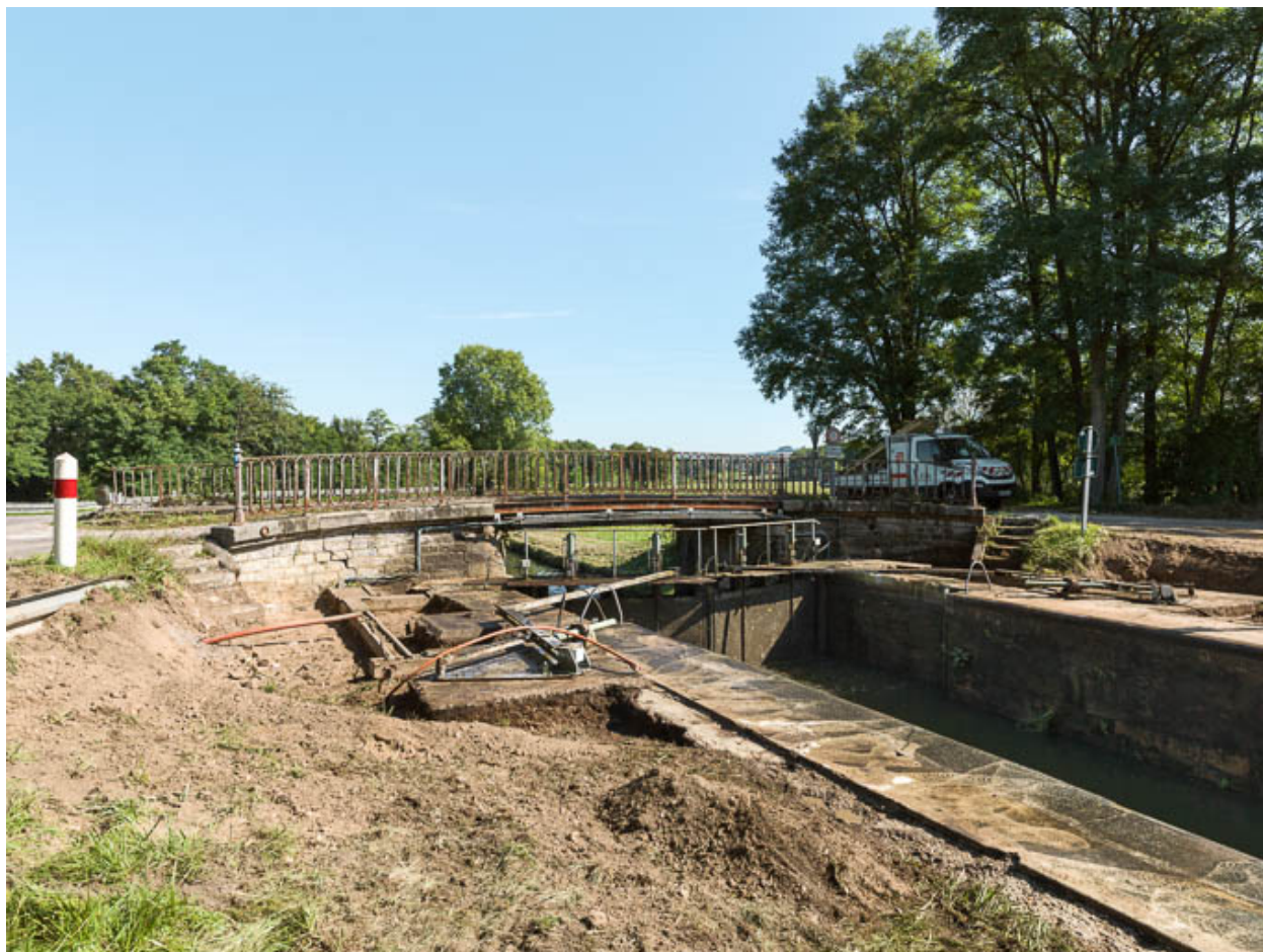
Vue d'ensemble du pont.
