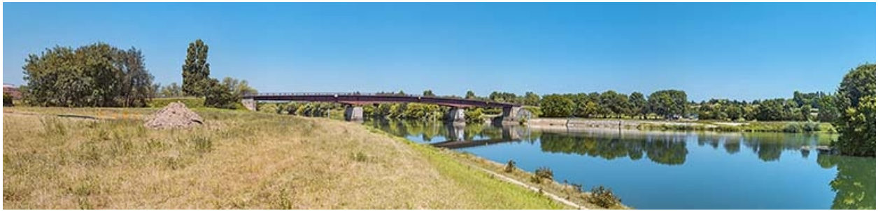
Le pont de Bragny vu d'amont depuis Verdun-sur-le-Doubs.
