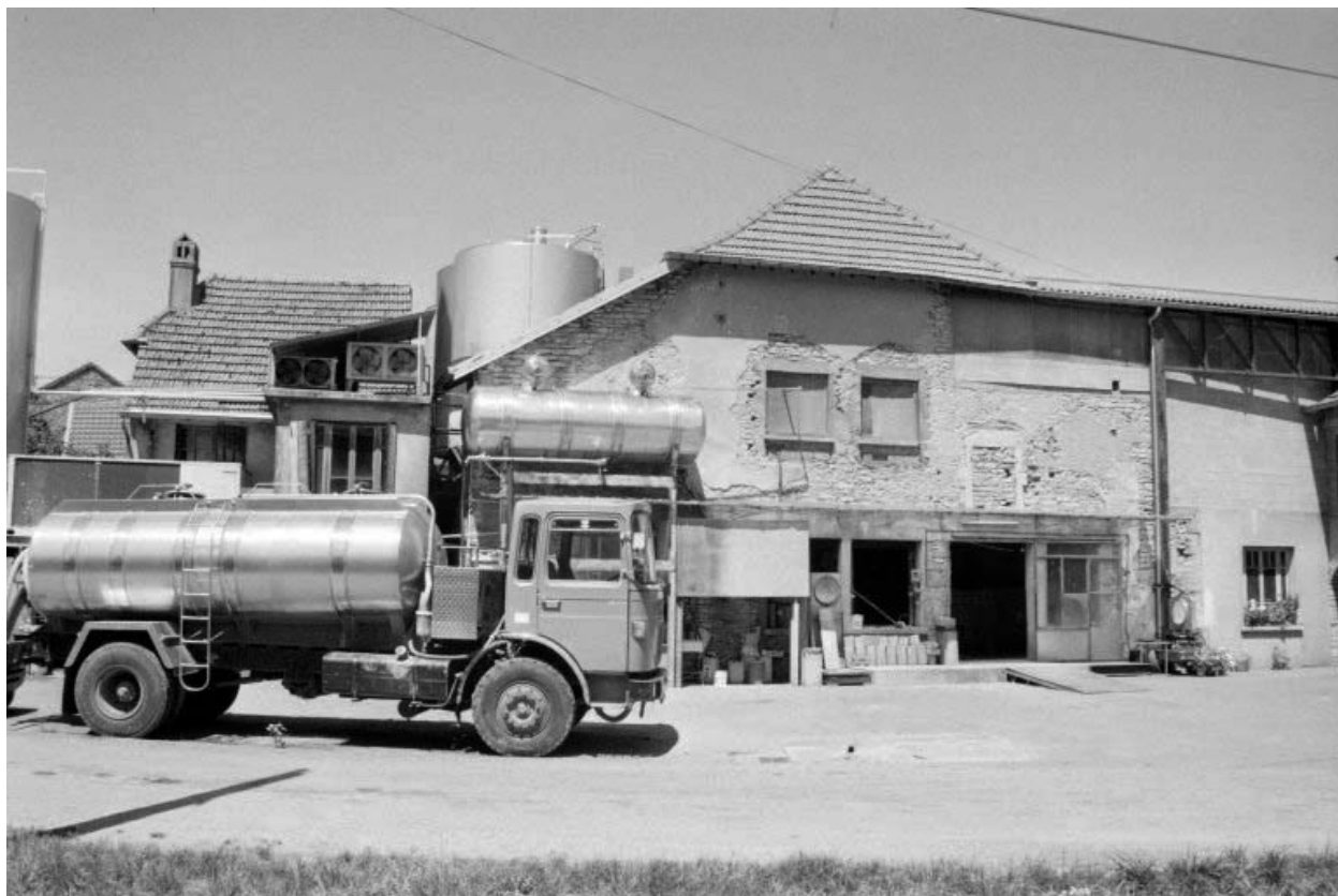
Façade antérieure de l'atelier de fabrication.
