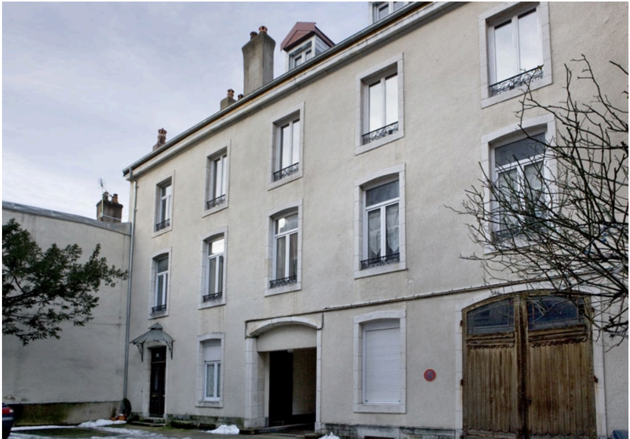
Vue d'ensemble du logis secondaire, de trois quarts droit.
