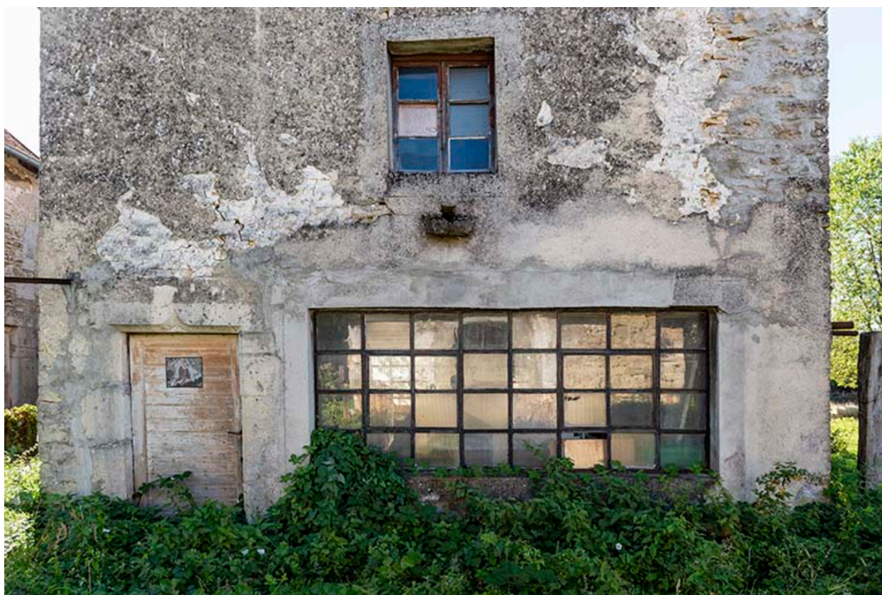
Forge, façade antérieure : porte et fenêtres.
