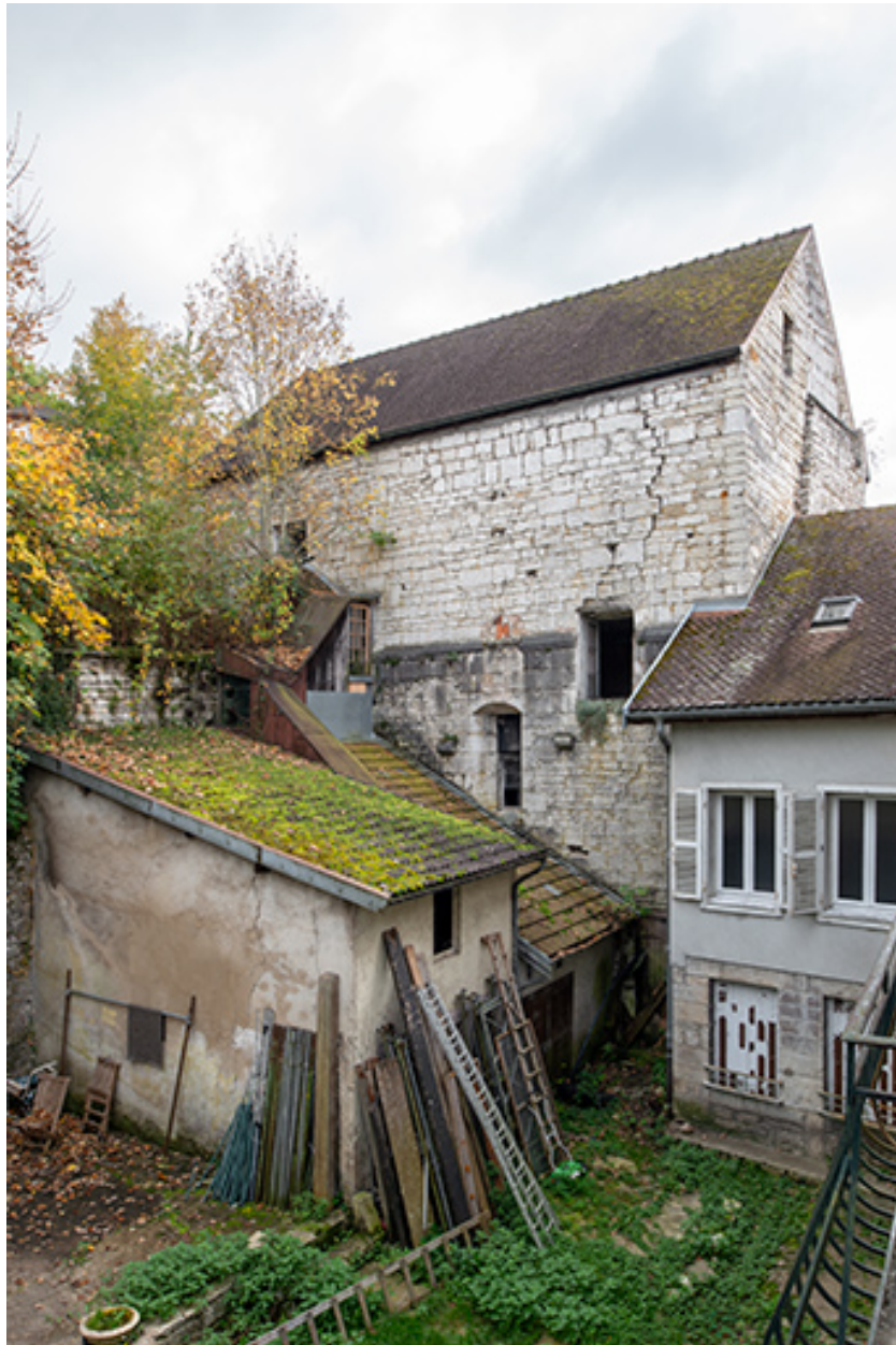
Façade nord de la chapelle, vue de trois quarts droite.
