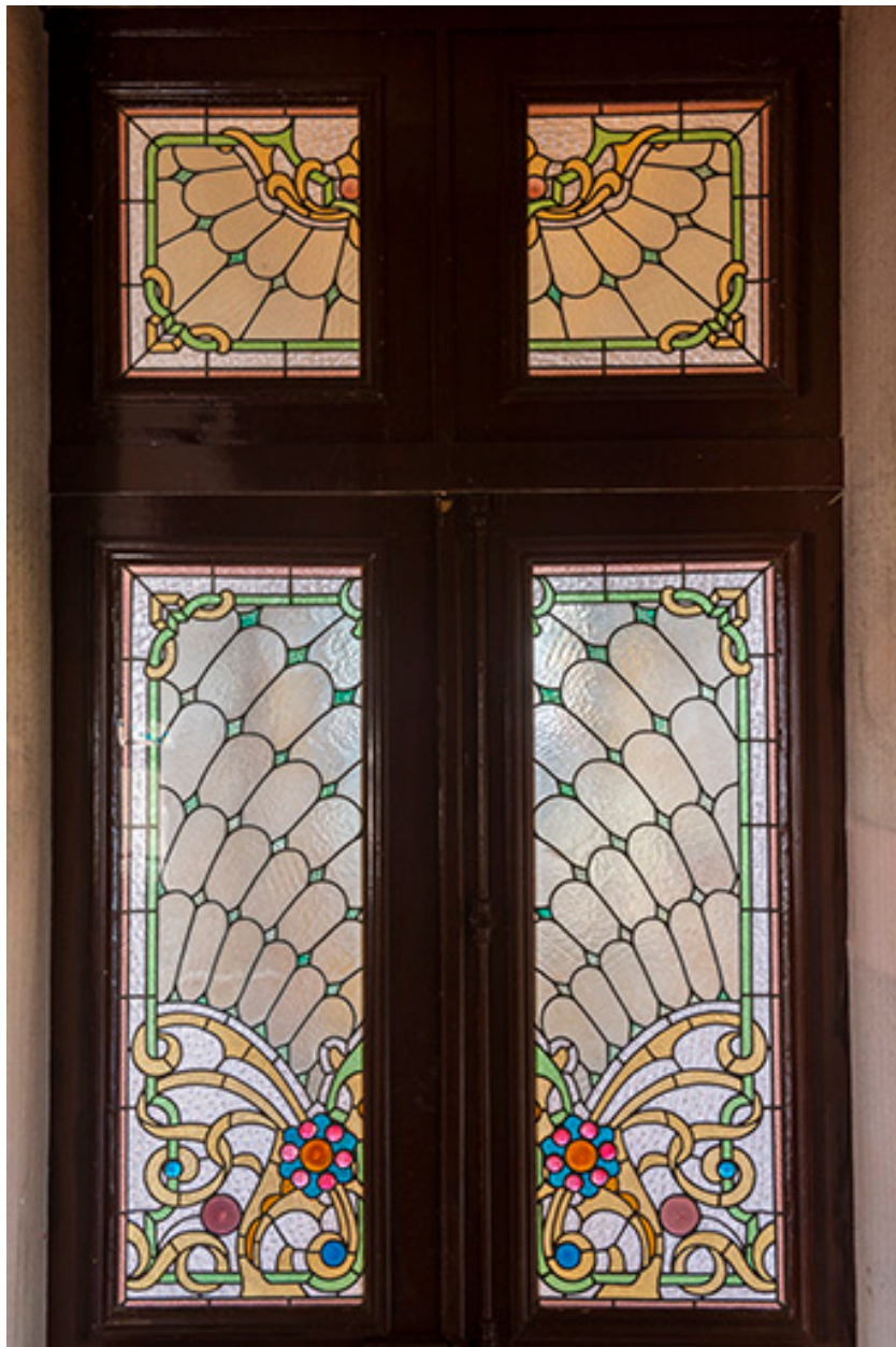
Porte du vestibule donnant sur la cage d'escalier, vitrail de style Art Nouveau.
